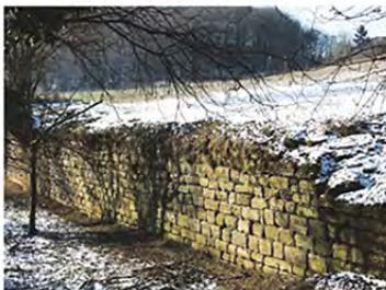
Abb.499-502 Ehemalige Weinbergsmauern in lagerhaftem Quadermauerwerk aus Wehrer Stein. Sie stützten den aufgelassenen ehemaligen Weinberg der Propstei ab und schützen ihn vor Unterspülung und Abtragung aus dem Tiefental. (Fotos: WM)
