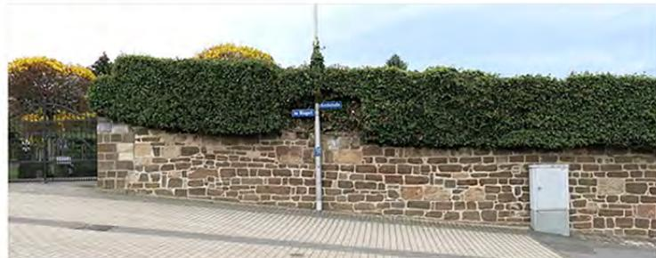
Abb.505 und 506 Übergang Kirchstraße / Im Wingert. Die aus Wehrer Steinen gesetzte Mauer zum Barockgarten wurde nachträglich mit den helleren Weilerner Tuffquadern erhöht. An einigen Stellen hat man größere Tuffsteine eingesetzt, die vermutlich aus einer früheren Erstverwendung stammen. Im barocken Garten zeigt die innere Mauer aus Wehrer Stein und Weilerner Tuff Nischen für Bienenkörbe. (Fotos: WM)
