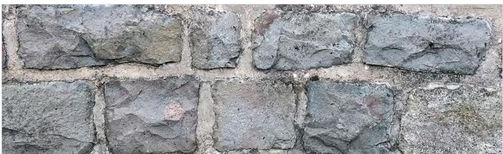
Abb.6 Bruchsteinmauer in Müllenbach aus Bocksberg-Gestein
