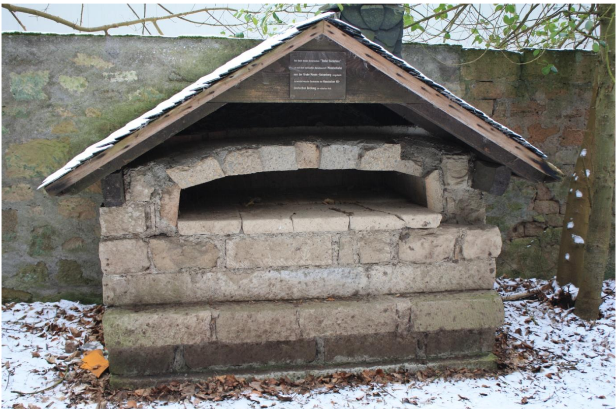
Abb. 31 Maria Laach, Natursteinlehrpfad, translozierter Steinbackofen aus Tuffsteinen ohne stirnseitige Ofenfront, etwa Ende 19. Jh.
