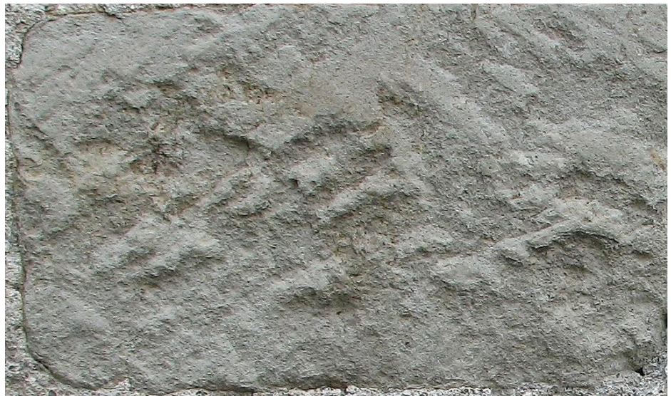
Abb. 5 Riedener Tuffstein, gebeilter Quader, Unterkante ca. 40 cm
