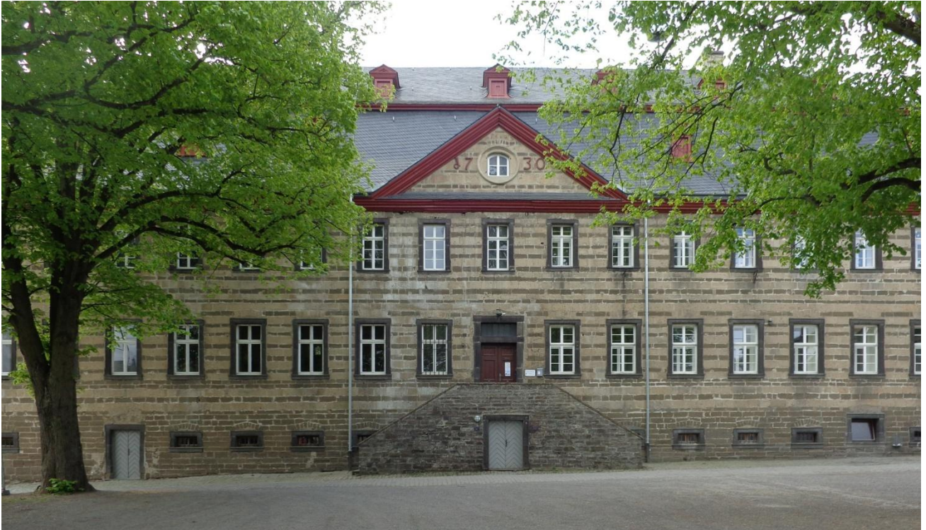
Abb. 15 Wehr, Propsteigebäude mit wechselnden Steinlagen von Weiberner und Wehrer Tuff, sog. „Specklagen“, 1730
