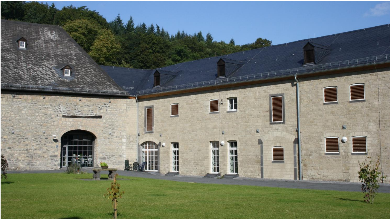
Abb. 19 Maria Laach, spätmittelalterliche Zehntscheune und Bibliothek im umgebauten Rinderstall
