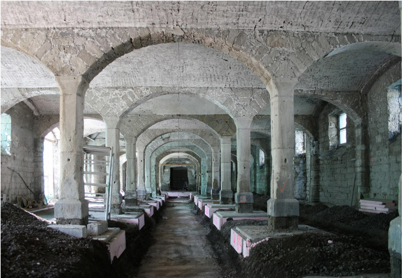
Abb. 18 Maria Laach, Rinderstall, 1863-1872, während der Sanierung im September 2012
