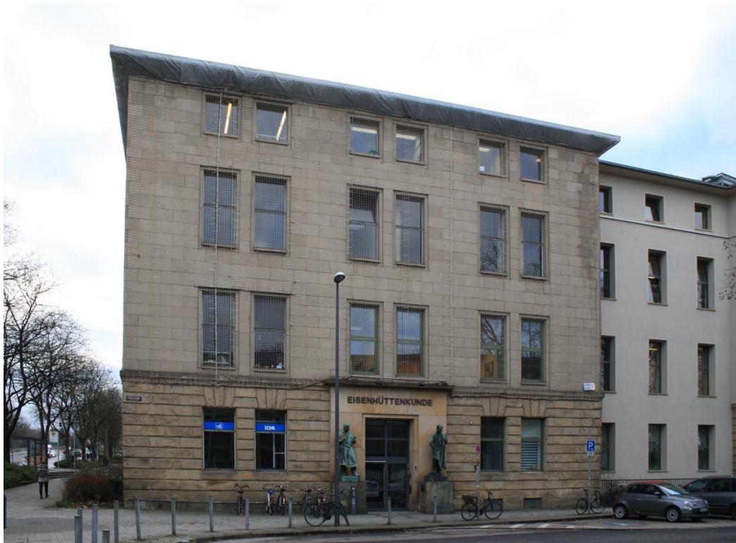
Abb. 45 Aachen, Intzestraße 1, RWTH, Institut für Eisenhüttenkunde, 1906-10, Verblendung in Weiberner Tuffsteinplatten über einem Bossenmauerwerk aus mittelkörnigen Sandsteinen
