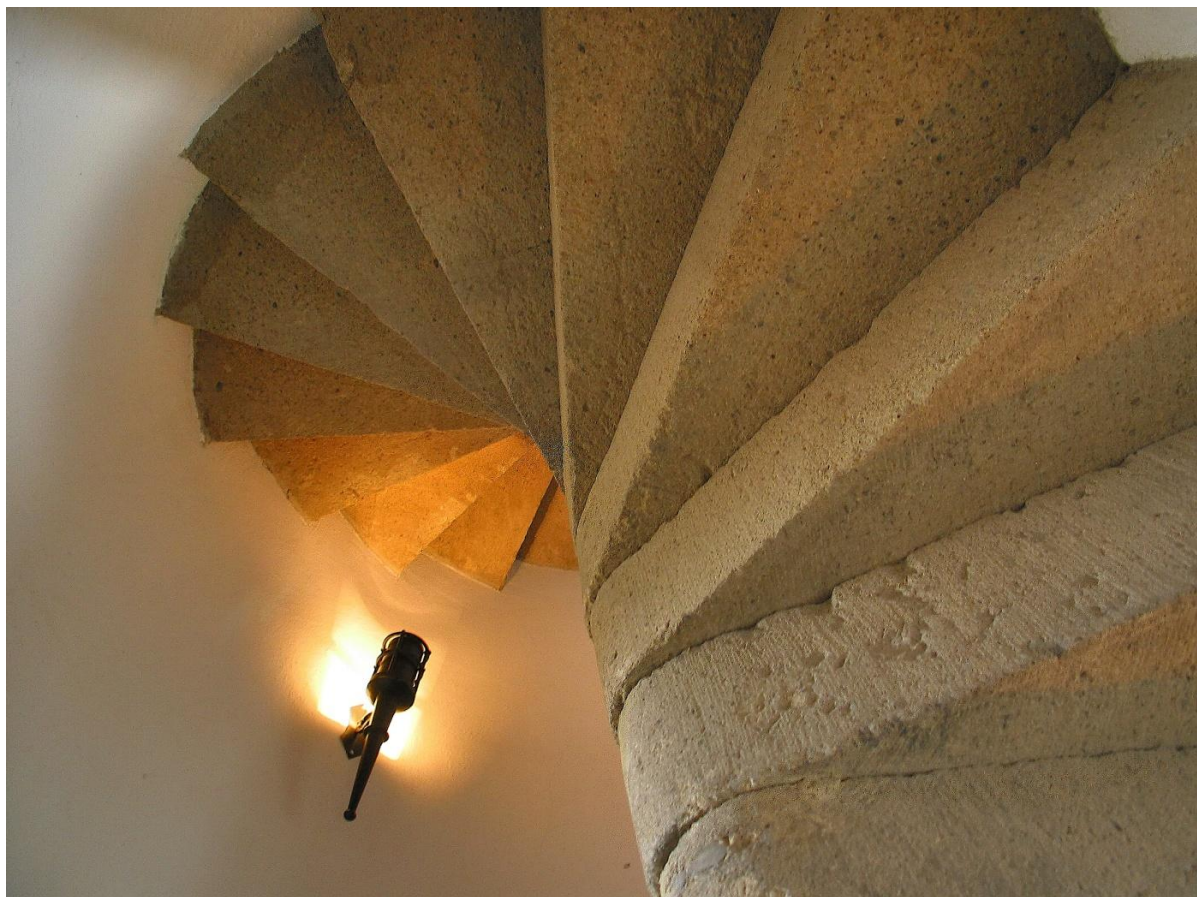
Abb. 12 Burg Olbrück, Spindeltreppe im Wehrturm aus Weiberner Tuffsteinen, um 1350 (Foto: WALTER MÜLLER)
