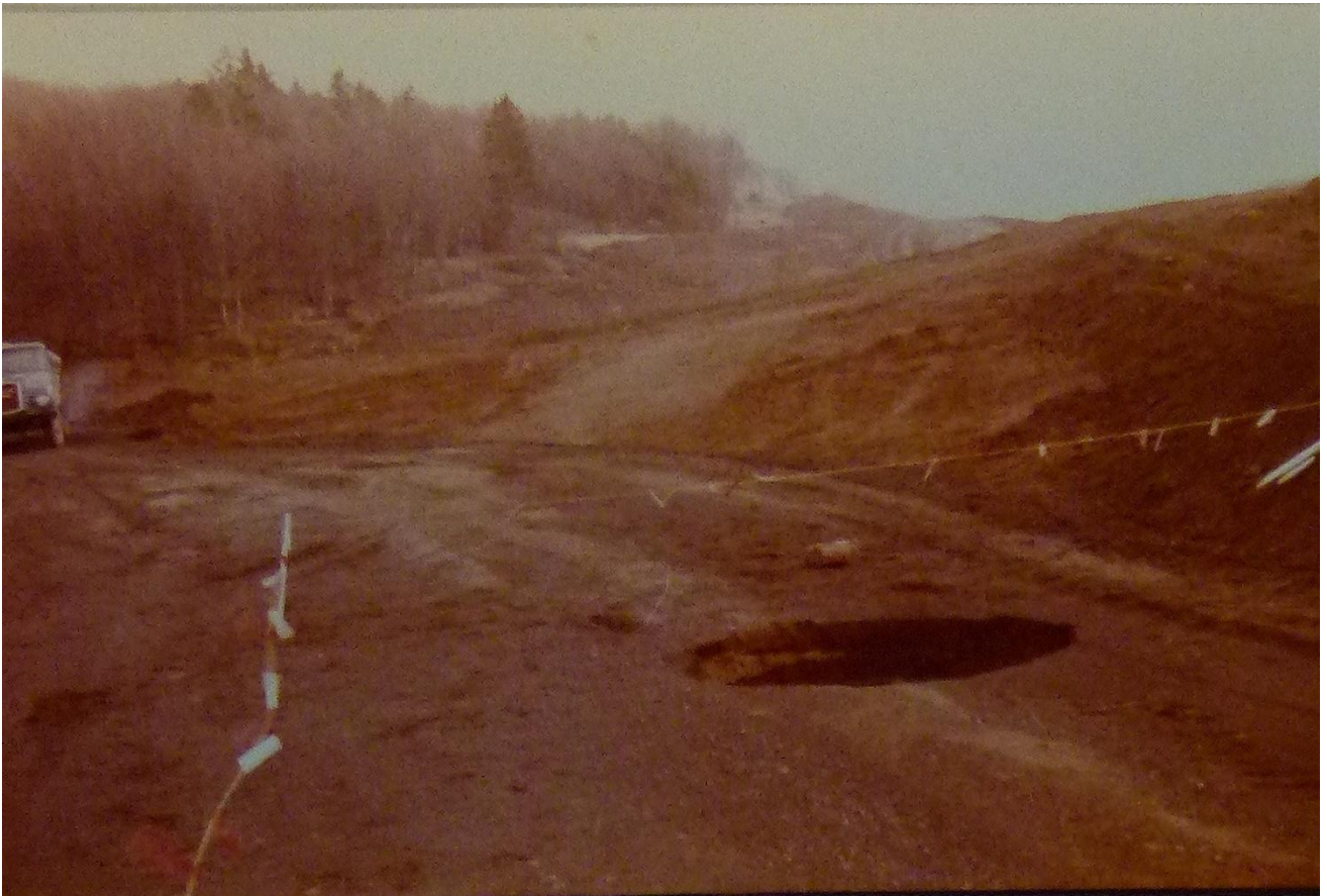
Abb. 6 Tagesbruch eines Untertageabbaus, Weiberner Tuff / RLPT 5, freigelegt beim Bau der B 412 Blick nach Osten in Richtung Wehr, 1974 (Foto: BRUNO ANDRÉ, Wehr)
