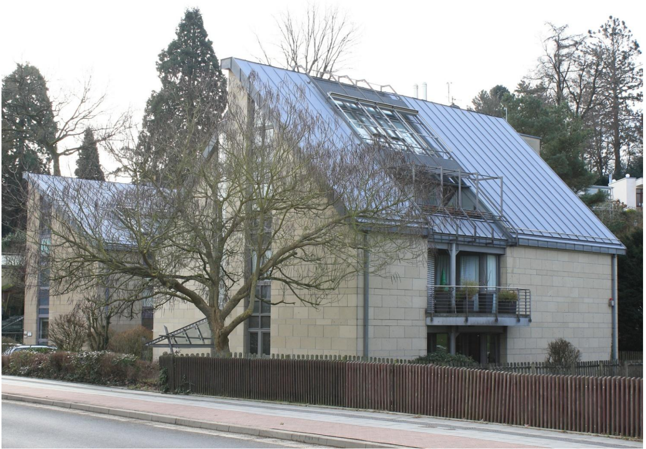
Abb. 48 Aachen, Südviertel, Brüsseler Ring, Büro- und Wohngebäudekomplex mit Fassadenverkleidung aus Weiberner Tuffsteinen, um 2000
