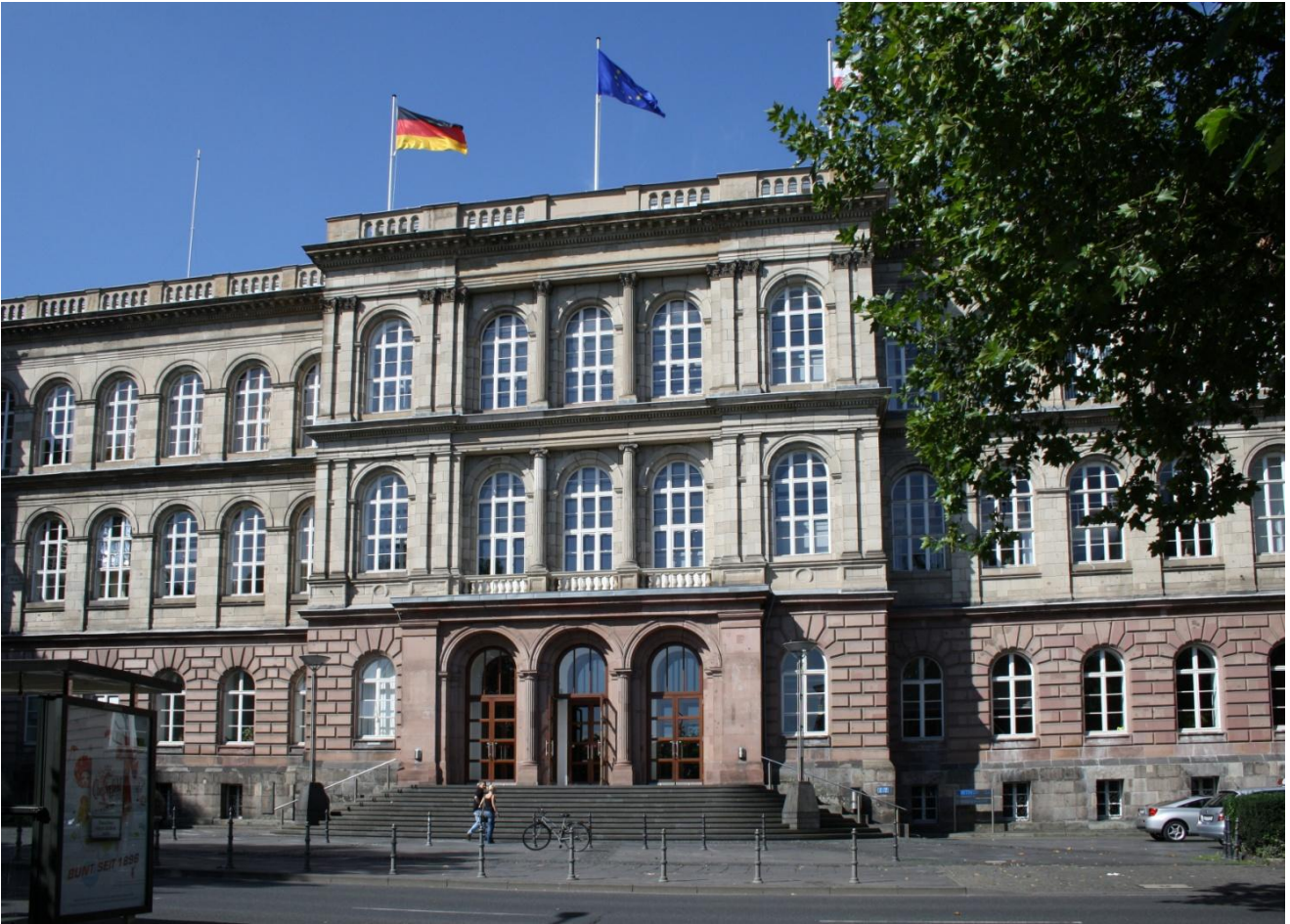
Abb. 20 Aachen, RWTH, Hauptgebäude am Templergraben, 1870
